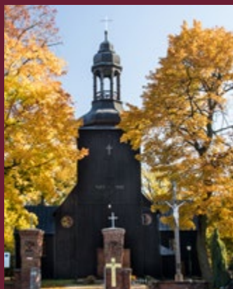
POPOWO KOŚCIELNE: KOŚCIÓŁ PW. ZWIASTOWANIA NMP
